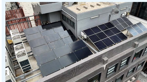
在長沙灣辦事處天台安裝太陽能電池板。
